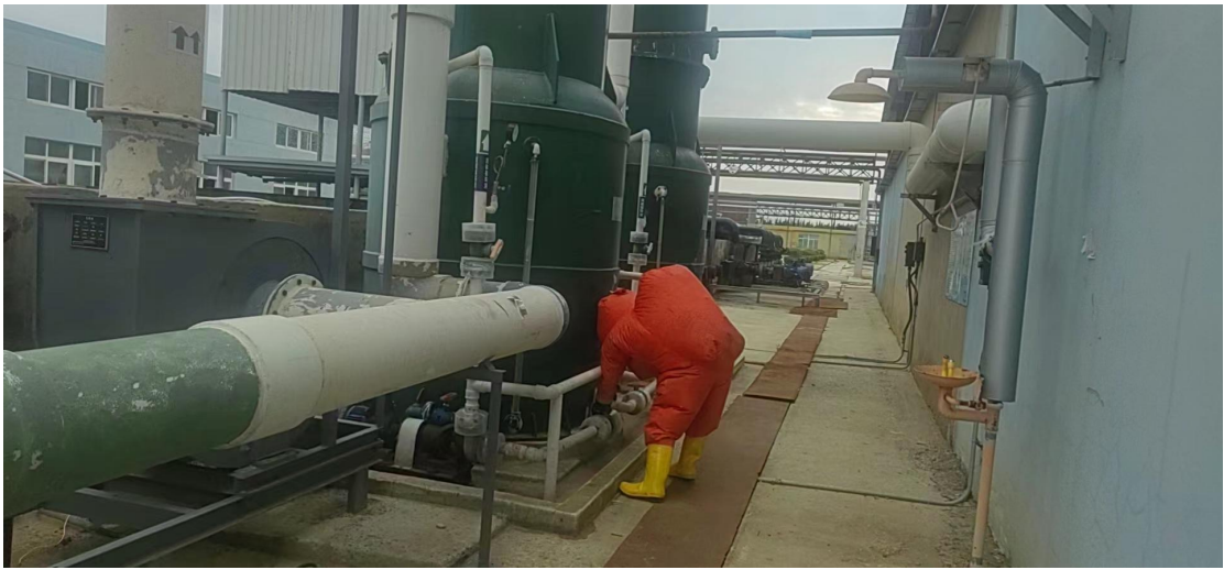
事故风机尾气吸收装置进行换碱作业
